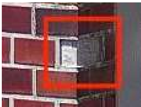
◆タイル剥落・欠損
